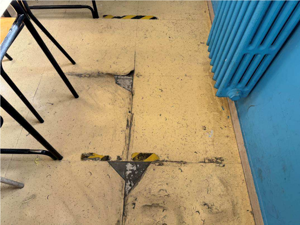
Foto n°3 (pavimento nelle aule)
