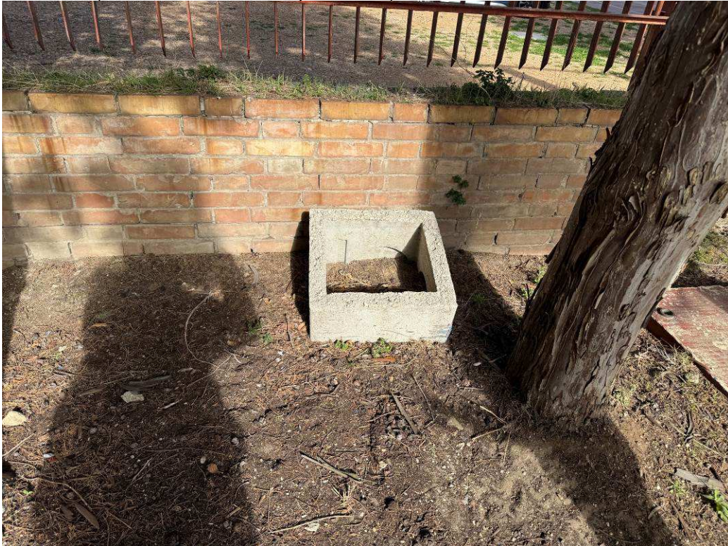
Foto n°49 (manufatti in cemento pericolosi)
