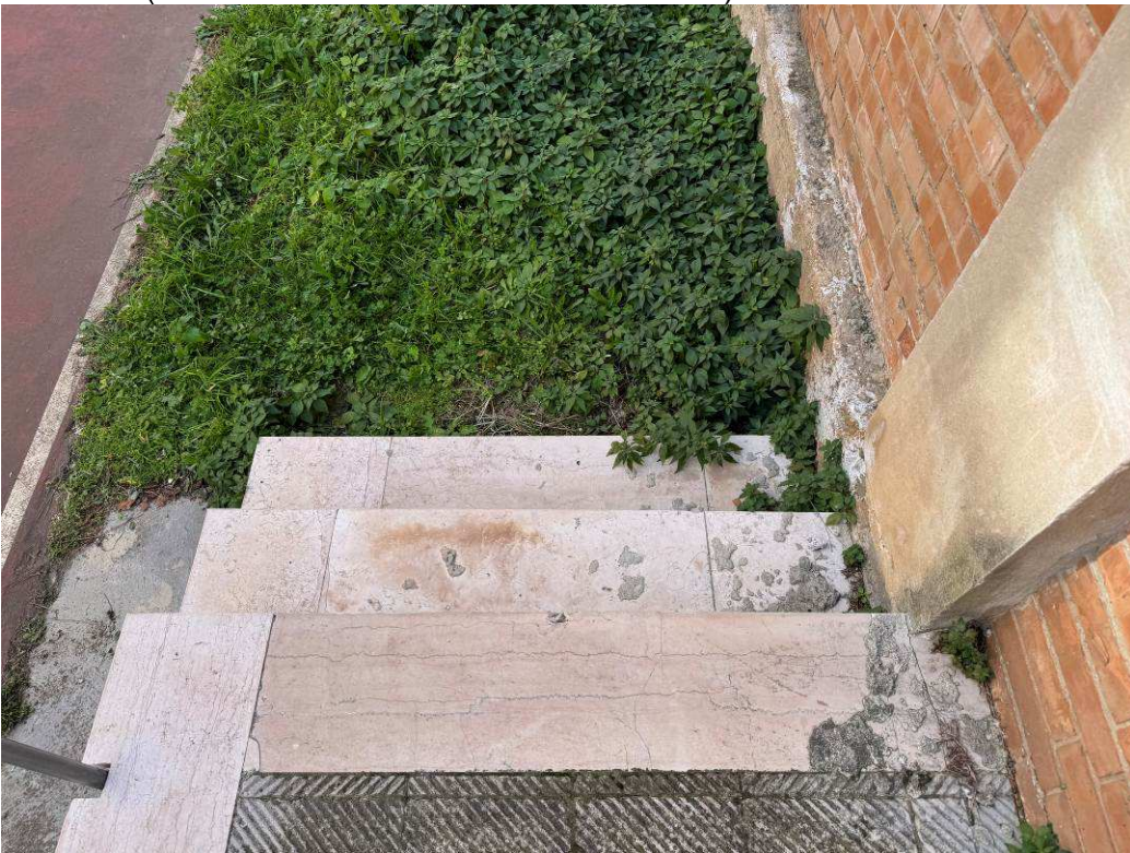
Foto n°52 (installare corrimano e band e antiscivolo)
